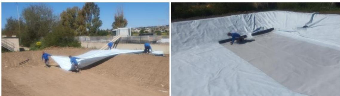
Figure 4. Etanchéité des lits de phytoépuration avec gaine PVC sur bâche TNT
