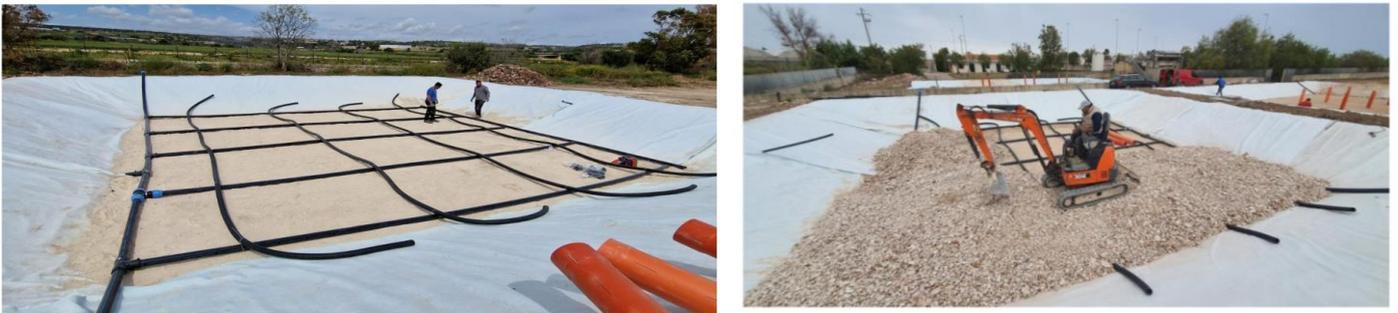
Figure 6: Lit à filtres plantés VF: tuyaux de drainage et d'aération (à gauche); installation d'un substrat de drainage dans le lit (à droite)
