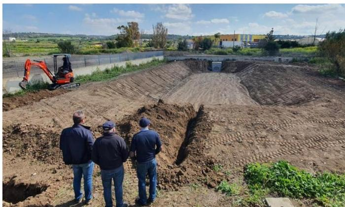
Figure 3: Phase d'excavation des lits de phytodépuration
