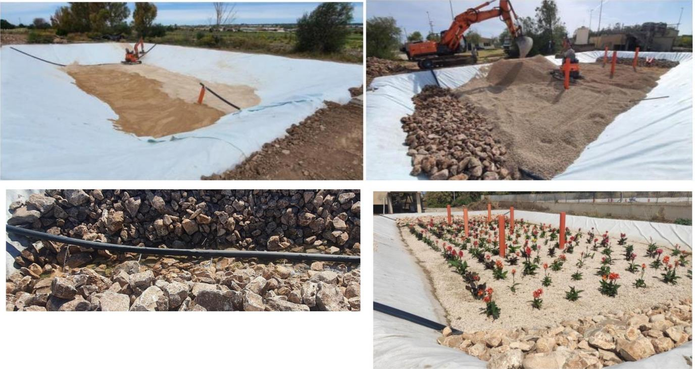
Figure 5. Lit à filtres plantés HF1 (dans le sens inverse des aiguilles d'une montre): pose de matériaux inertes; conduite de distribution; lit à filtres plantés HF1 complet (juin 2023)
