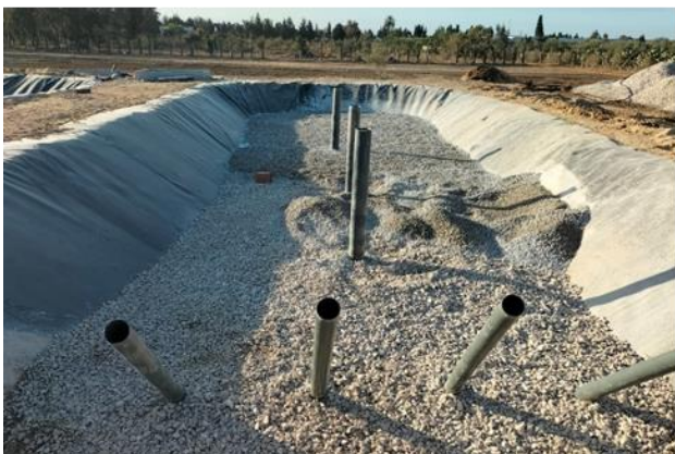
Figure 5. Etapes de construction et d'installation des pilotes: creusage des bassins; pose de la membrane géotextile; pose de la géomembrane; remplissage des bassins par le substrat ; pose des drains; plantation et installation des conduites de distribution de l'eau
