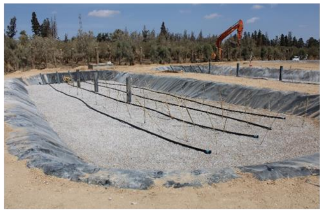
Figure 5. Etapes de construction et d'installation des pilotes: creusage des bassins; pose de la membrane géotextile; pose de la géomembrane; remplissage des bassins par le substrat ; pose des drains; plantation et installation des conduites de distribution de l'eau
